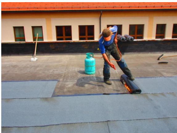
Pokládka nového povrchu střechy kotelny
