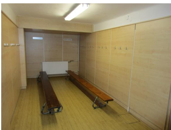
Rekonstrukce šatny tělocvičny (obložení)
