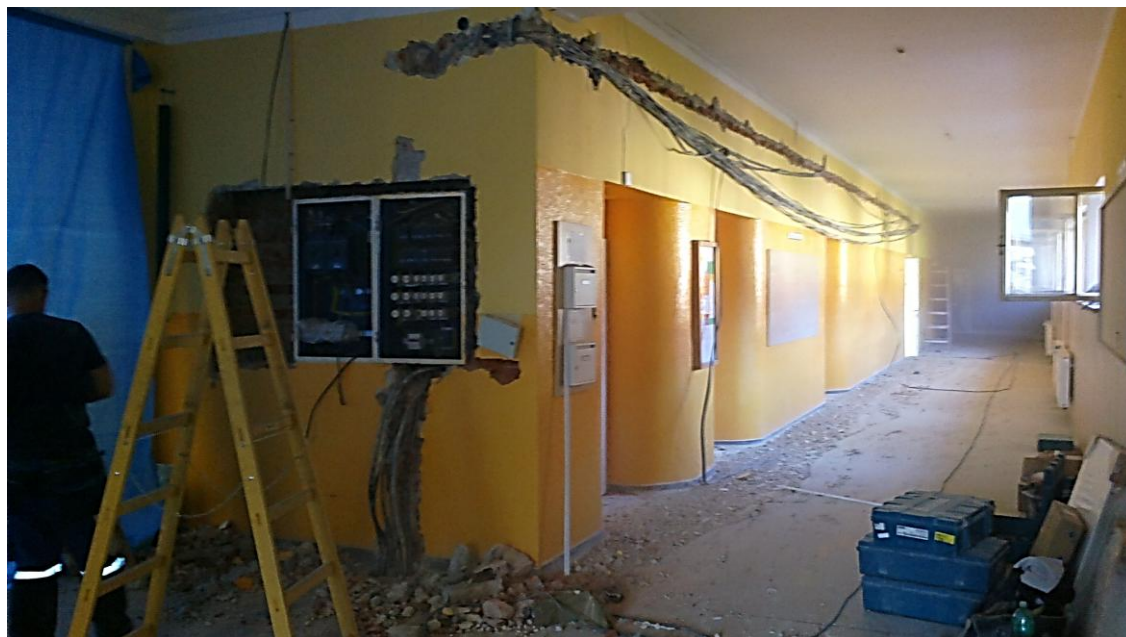
Příloha č. 7: Výměna elektroinstalace ve staré budově (realizován suterén a ředitelské patro včetně družin a kabinetu TV). Chodba staré budovy před a po rekonstrukci.
